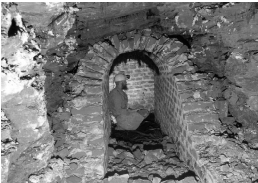
Josefov – vybouraná vyzdívka z minové chodby. Na snímku je patrné, že chodba byla ražena ve skalním masívu – ve vápňitých slínovcích – „opukách“ (foto R. Tásler).
